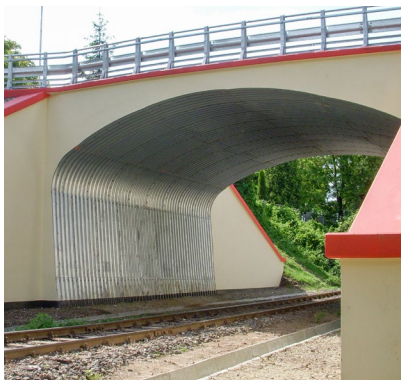
Betonkragen – rechtwinkliges Ende
