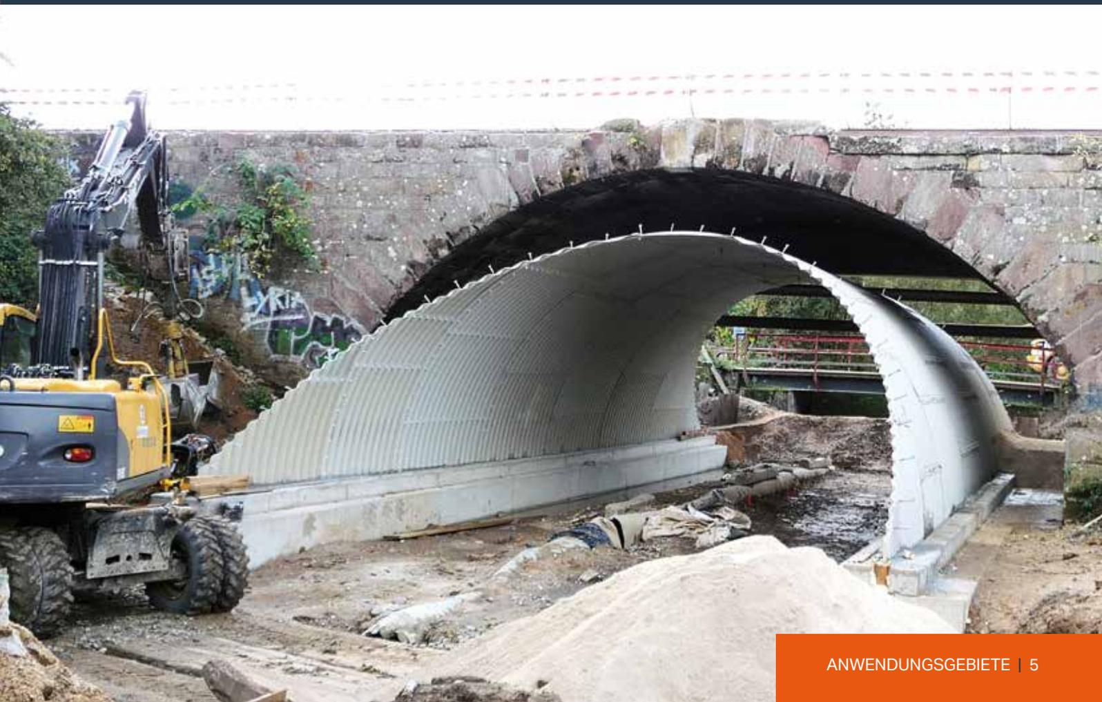
Egal ob wasser- oder verkehrsführende Bauwerke - der klassische Einbau eines Wellstahlbauwerkes erfolgt in der Regel in der offenen trockenen Baugrube. Hierbei werden die Stahlfertigteile in entsprechender Reihenfolge – Boden-, Eck- und anschließend Deckenbleche – montiert. Nach sach- und fachgerechter Montage erfolgt die bauseitige lagenweise Hinterfüllung in vorgegebenen Schüttlagen.
