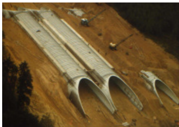
Bild 3: Grünbrücke Nationalpark WoesteHoeve (NL) im Bauzustand
