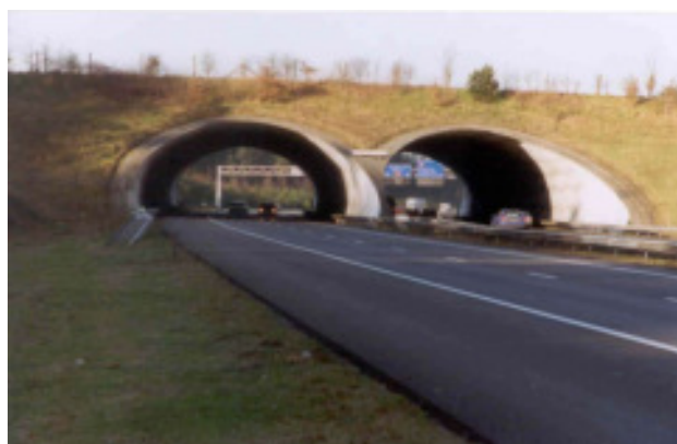
Bild 4: Grünbrücke Nationalpark Woeste Hoeve (NL) im Endzustand
