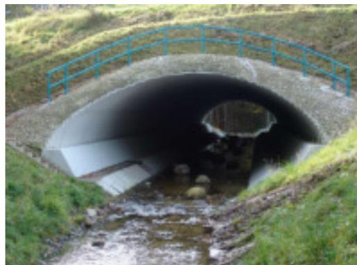
**Bild 4:** Fertiggestelltes Wellstahlbauwerk
