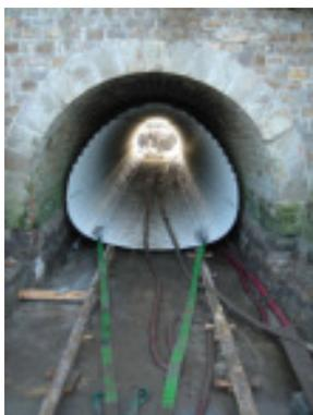
Zumauern des Zwischenraumes mit Entlüftungs- bzw. Kontrollöffnungen hergestellt werden. Bei gleichzeitiger Verlängerung werden die aus dem vorhandenen Bauwerk heraus stehenden Bereiche, z.B. die Böschungsstücke, mit Bodenmaterial lagenweise hinterfüllt. Nach kurzer Abbindezeit des Verfüll-
