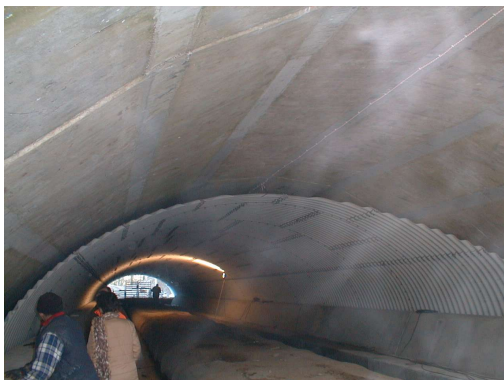
Bild 3: Einziehen des Hamco-Wellstahlbauwerkes in das zu sanierende Polygon-Betonbauwerk ohne Beeinträchtigung des Autobahnverkehrs
